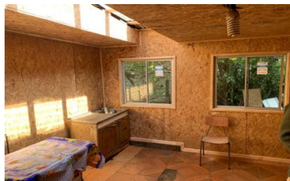
MEJORAMIENTO INTERIOR DE COCINA
